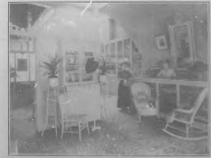
Vista interior de la casa Dolly Soeurs.
