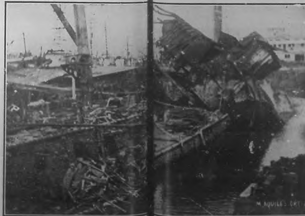
OTRO ASPECTO DEL "MAINE" TRABAJOS DE EXTRACCIÓN.
