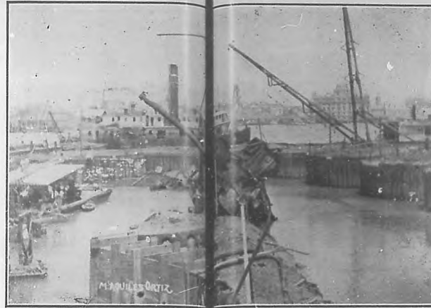
ASPECTO DEL "MAINE" TRABAJOS DE EXTRACCIÓN
